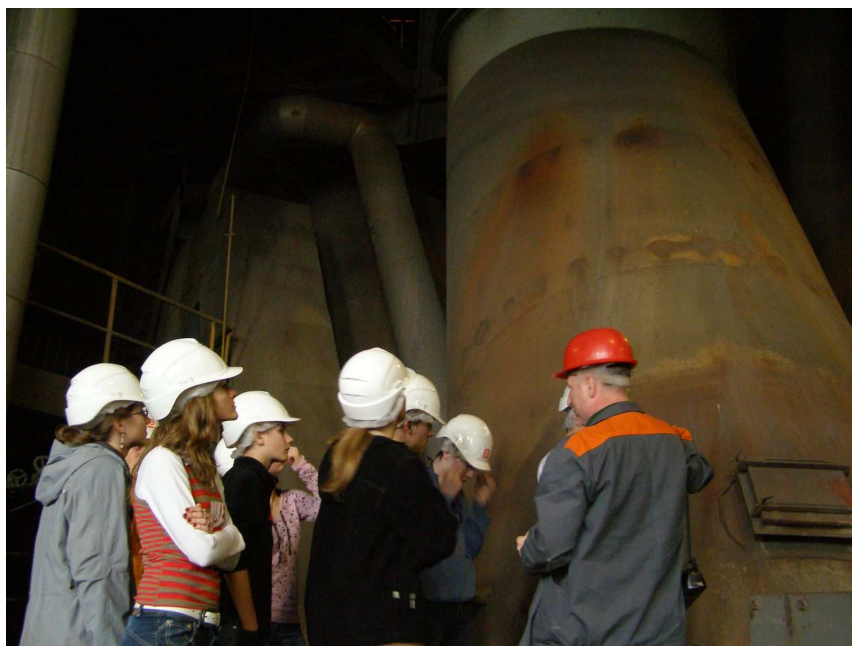
V útrobách tepelné elektrárny Mělník
